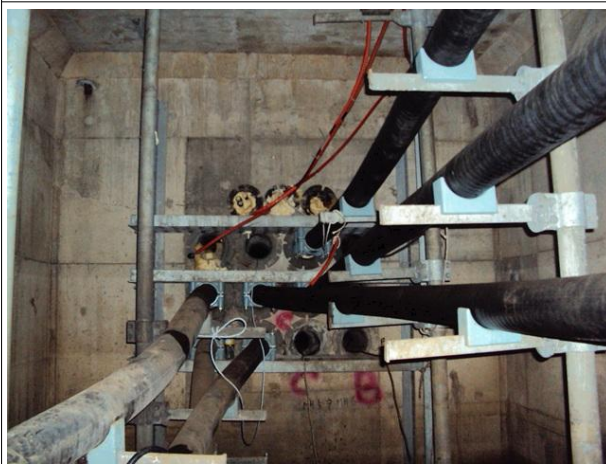
관로부 전경 상태양호
