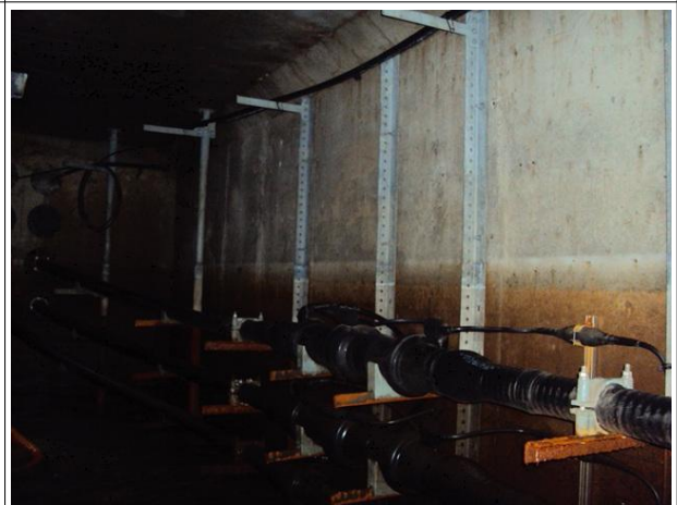
관로부 전경 상태양호
