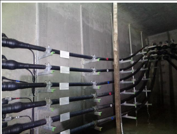
벽체 전경 및 상태양호
