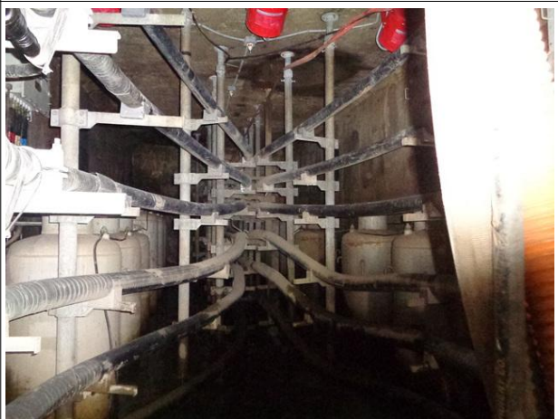
벽체 및 관로부 전경
