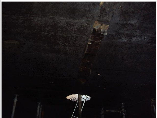
슬래브 거푸집 미제거
