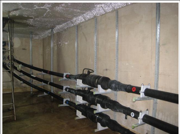
벽체 전경 상태양호
