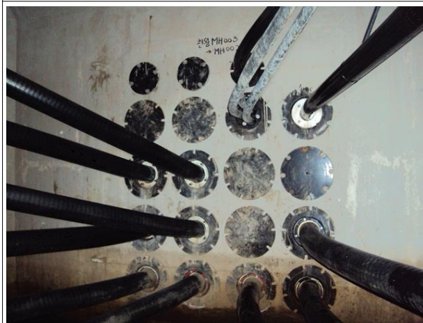
관로부 전경 및 상태양호
