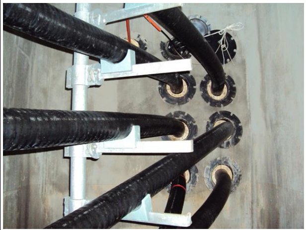
관로부 전경 상태양호
