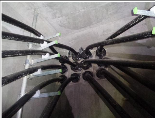
관로부 전경 및 상태양호
