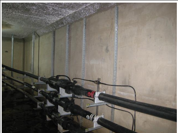
벽체 전경 상태양호
