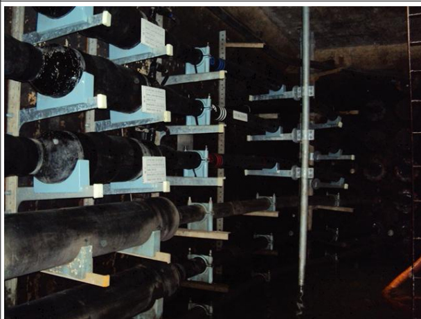
벽체 전경 상태양호
