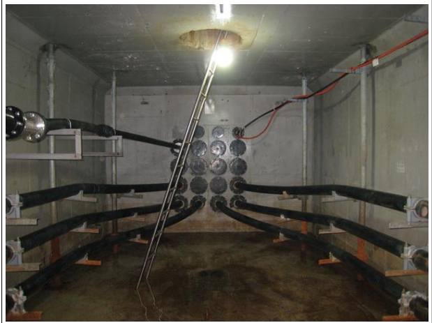
내부 관로부 전경
