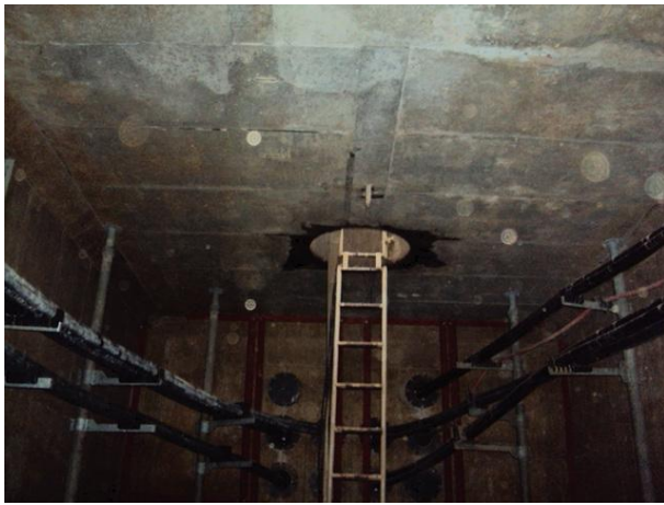
슬래브 전경 상태양호
