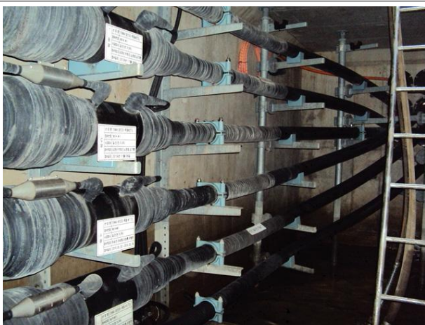
벽체 전경 상태양호
