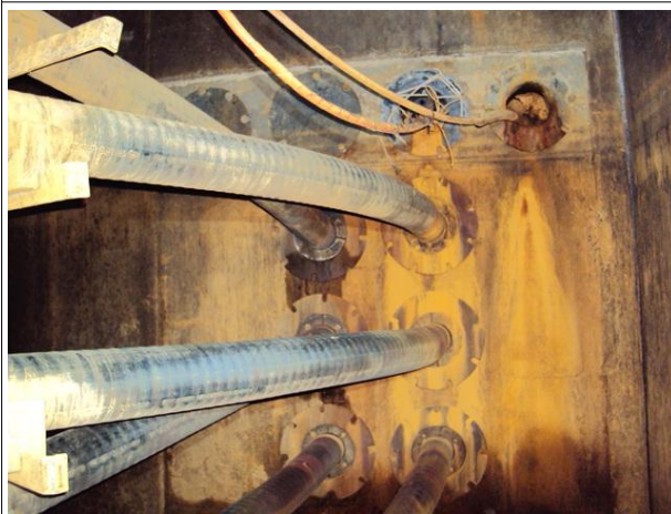
관로부 전경 상태양호
