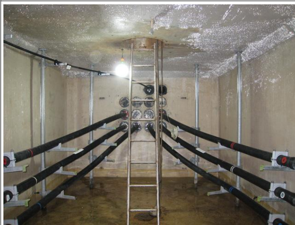
관로부 전경 상태양호
