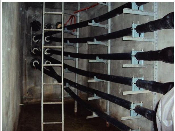
벽체 전경 상태양호
