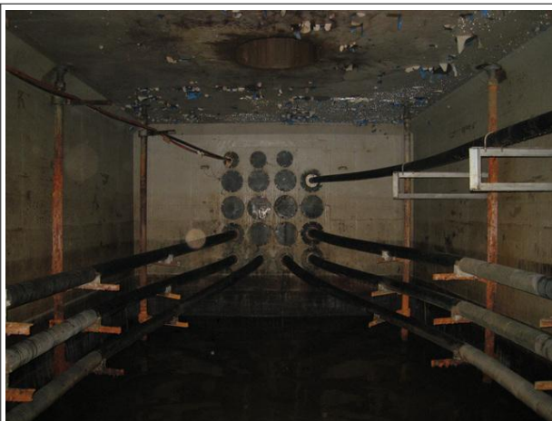
내부 관로부 전경
