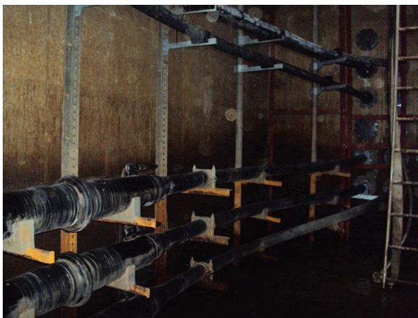
벽체 전경 상태양호
