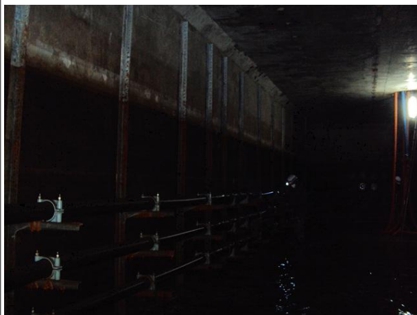
벽체 전경 상태양호
