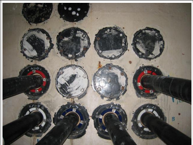
관로부 전경 상태양호
