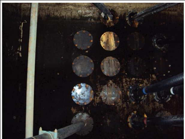
관로부 전경 상태양호
