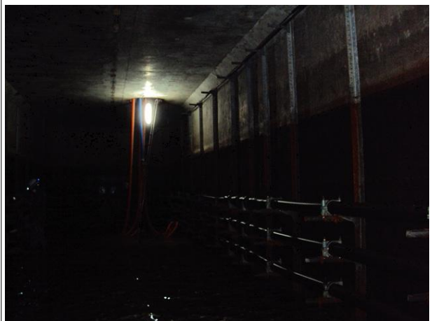
벽체 전경 상태양호
