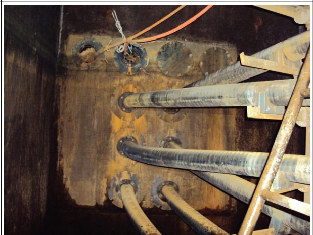
관로부 전경 상태양호
