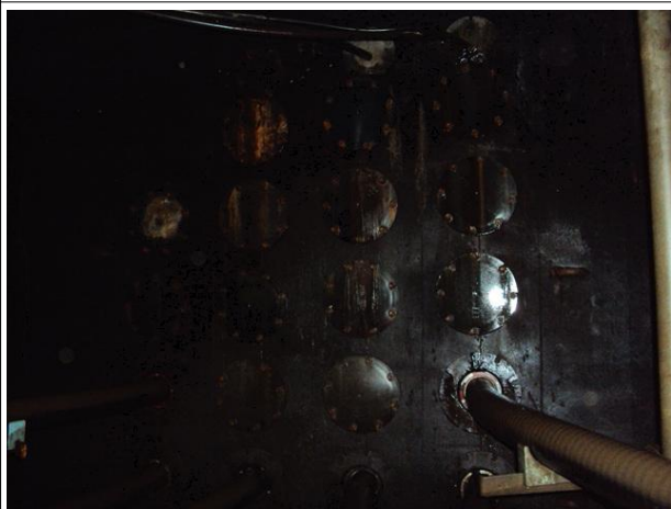
관로부 전경 상태양호
