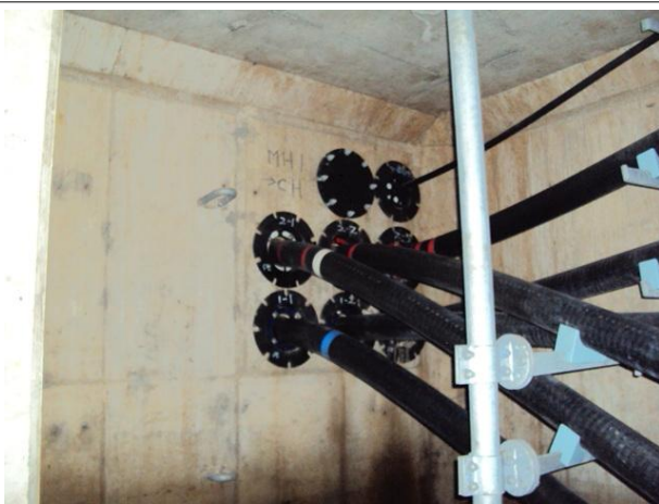
관로부 전경 상태양호
