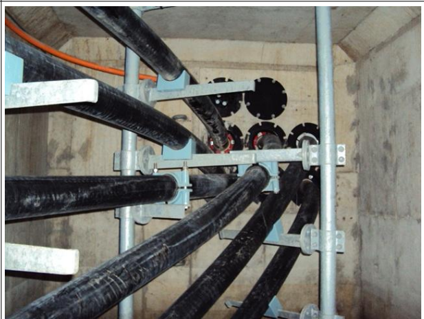
관로부 전경 상태양호
