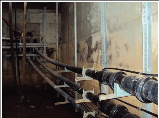
벽체 전경 상태양호
