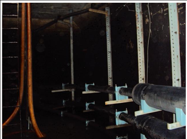
벽체 전경 상태양호
