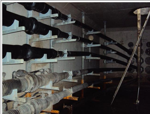
벽체 전경 및 상태양호
