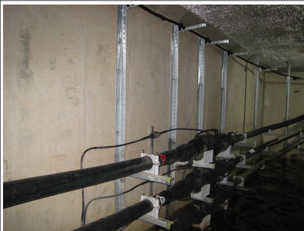
벽체 전경 상태양호
