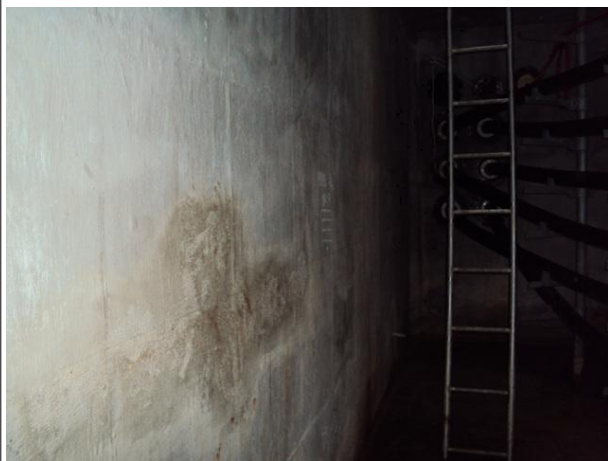
벽체 전경 상태양호
