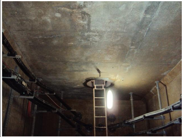
슬래브 전경 상태양호
