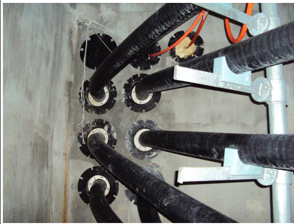
관로부 전경 상태양호
