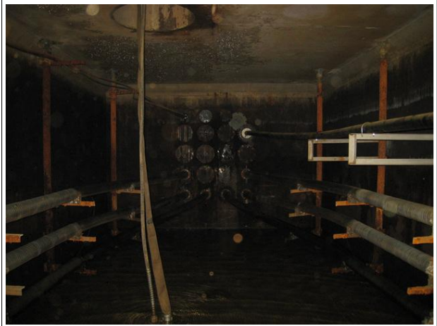
내부 관로부 전경
