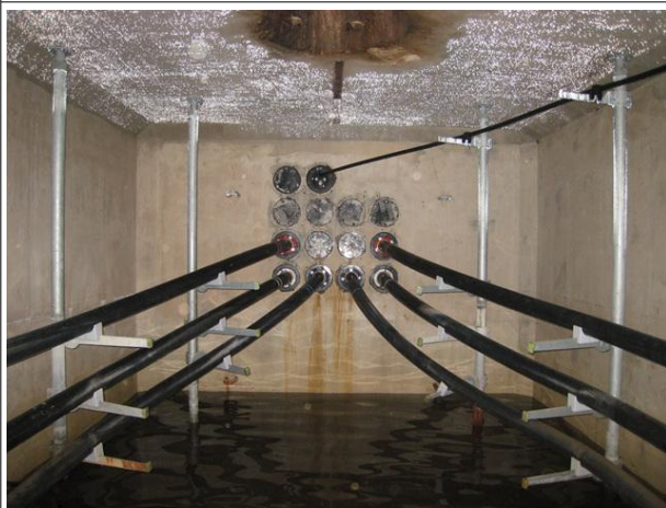
관로부 전경 상태양호
