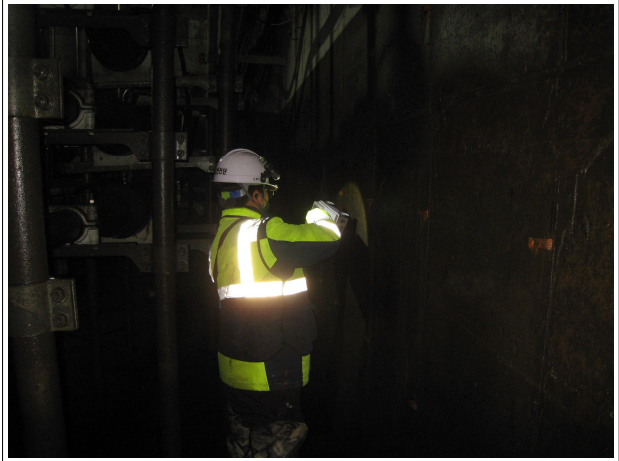
맨홀 내부 육안조사
