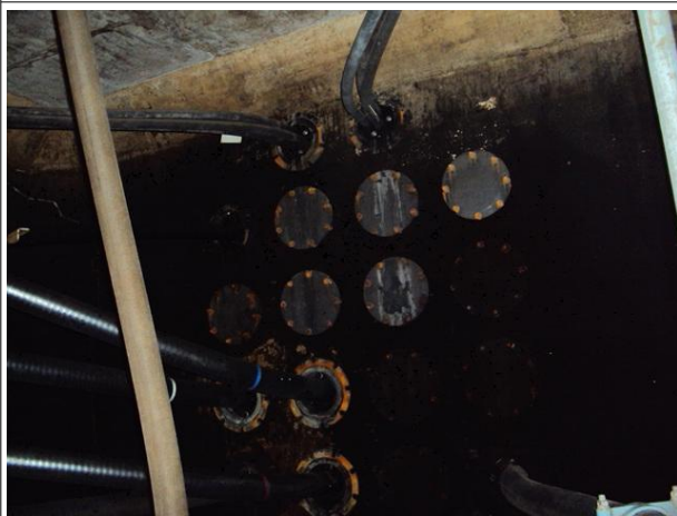
관로부 전경 상태양호
