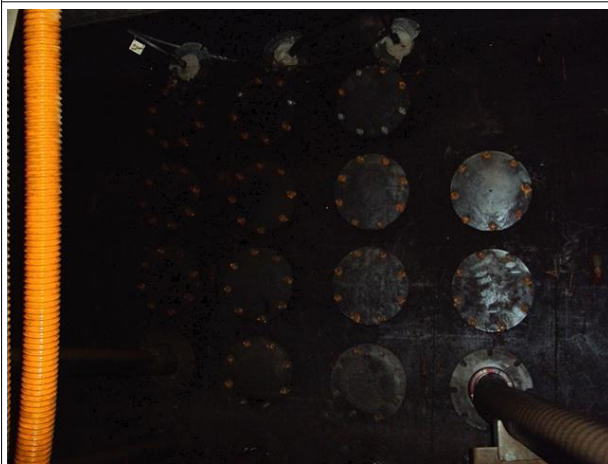
관로부 전경 상태양호
