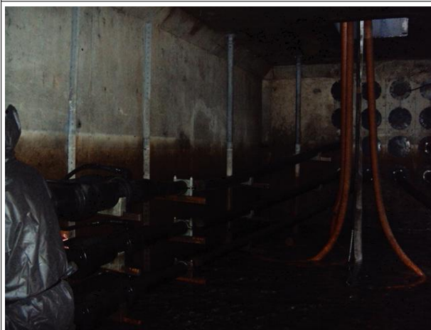
관로부 전경 상태양호
