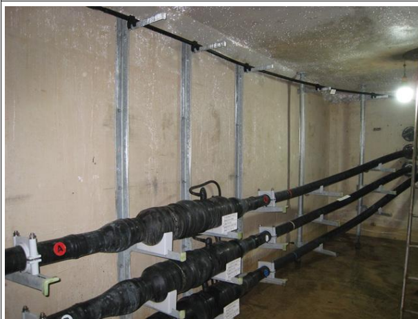
벽체 전경 상태양호
