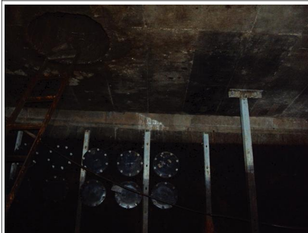
벽체 균열부 백태
