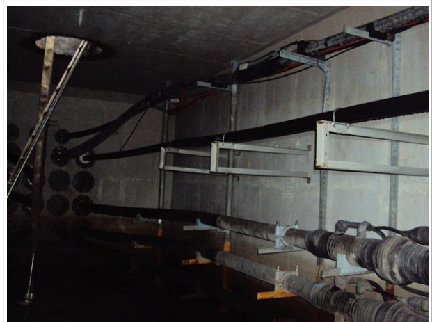
벽체 전경 및 상태양호
