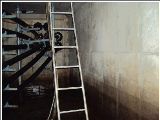
벽체 전경 상태양호
