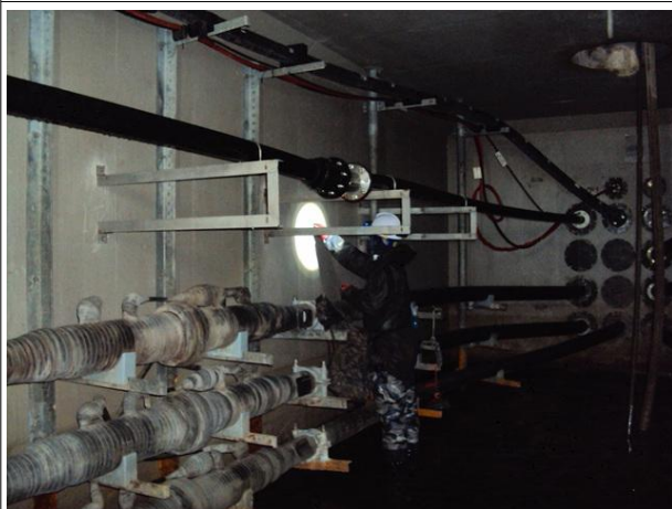
벽체 전경 및 상태양호
