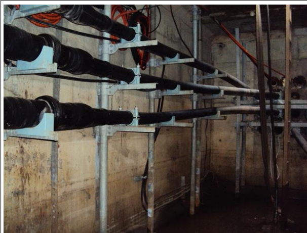
벽체 전경 상태양호
