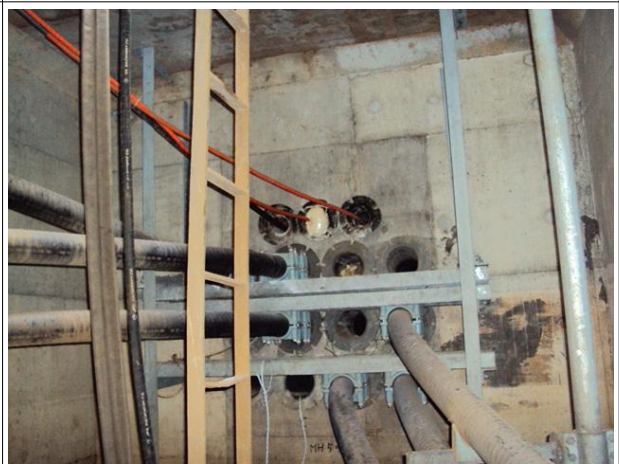
관로부 전경 상태양호
