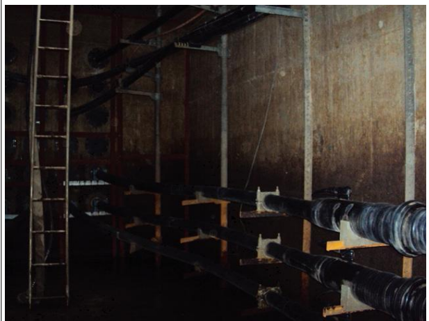
벽체 전경 상태양호
