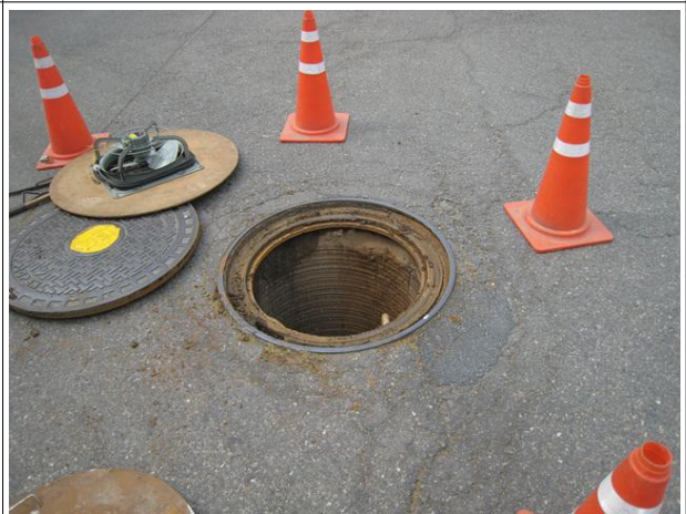
포장부 맨홀2번 포장파손 보수
