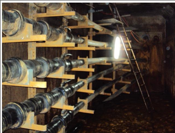
벽체 전경 상태양호
