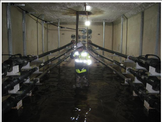
관로부 전경 상태양호
